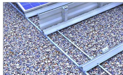
toit plat sud I sur toiture gravier
